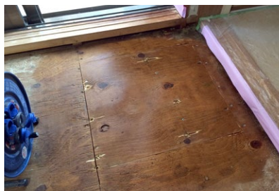
フローリングや畳を敷く前の荒床の処理
