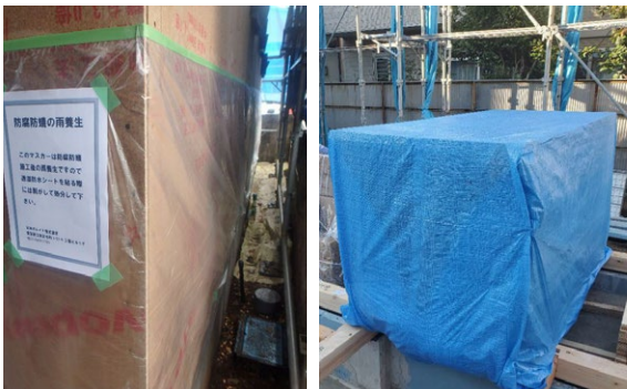
雨養生：処理部位・部材のマスカーやブルーシートでの保護の例
